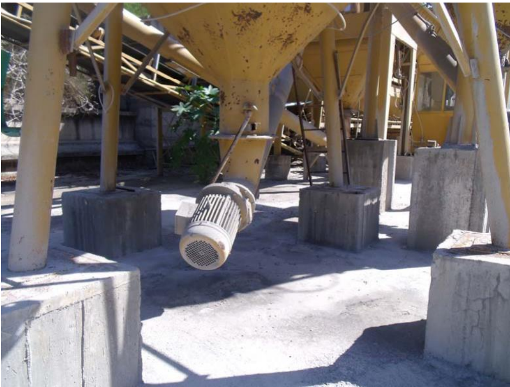
Foto n. 53: Fondazioni impianto di calcestruzzo.
