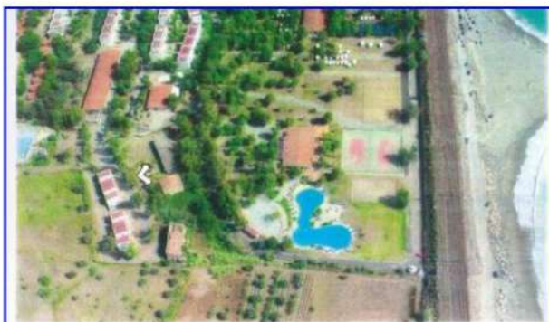
Foto 7. PANORAMICA DA NORD CON INDICAZIONE DEL SITO D'INTERVENTO (CON I DUE FABBRICATI DA DEMOLIRE INDICATI DALLA DOPPIA FRECCIA BIANCA). SONO VISIBILI PARTE DELLE STRUTTURE DEL VILLAGGIO CIRCOSTANTI AL SITO IN OGGETTO.
